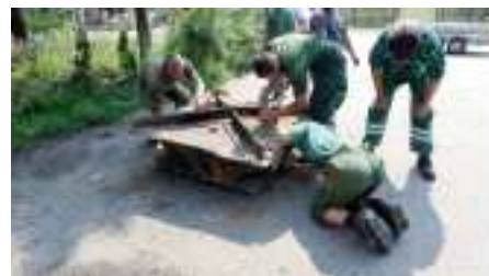
Widok wydobytej płyty nogi fundamentu masztu pierwszego
