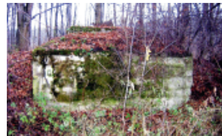
Fundament nogi masztu czwartego
