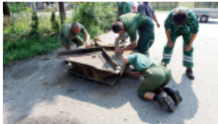
Widok wydobytej płyty nogi fundamentu masztu pierwszego
