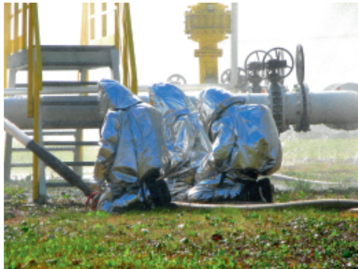
ubrania ochronne "żarowe" typu ciężkiego chronią strażaków przed promieniowaniem cieplnym
