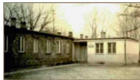
Budynek Szkoły w Babicach przy ul. Kresowej 1 zbudowano w 1947 roku, w 1957 roku dobudowano szatnię i wejście. 25 stycznia 1994 roku budynek uległ spaleni, a potem został rozebrany
