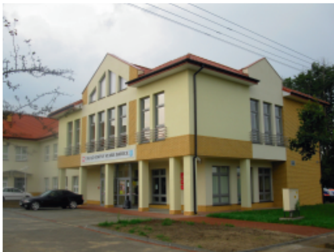
nowy, gminny budynek komunalny oddany w tym roku
