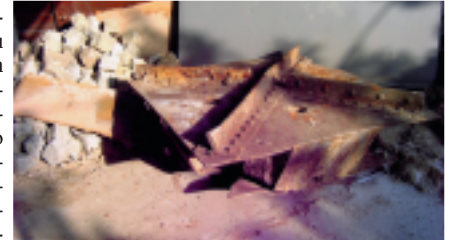
wydobyta górna stalowa płyta nogi masztu (05.09.2011.)
