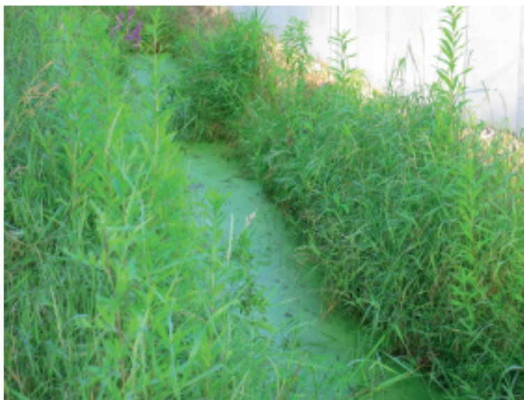
stan rowu Z-11 w Klaudynie nie gwarantuje prawidłowego odbioru wody
