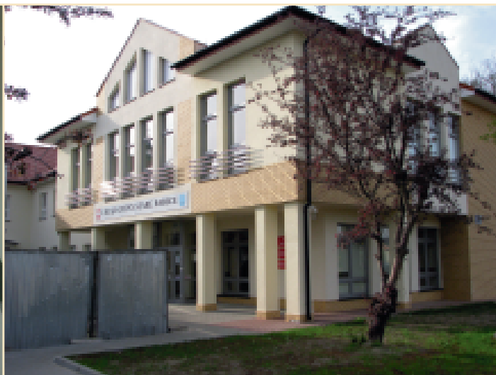
NOWY BUDYNEK KOMUNALNY PRZY UL. RYNEK 21
