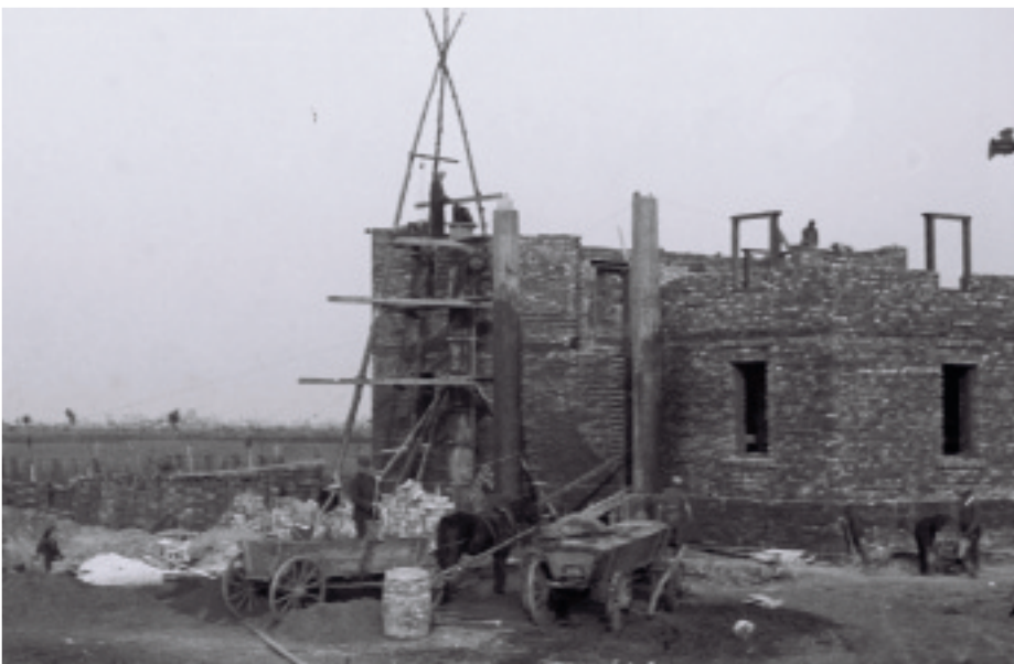
front budynku - na archiwalnym zdjęciu widoczne są betonowe kolumny
