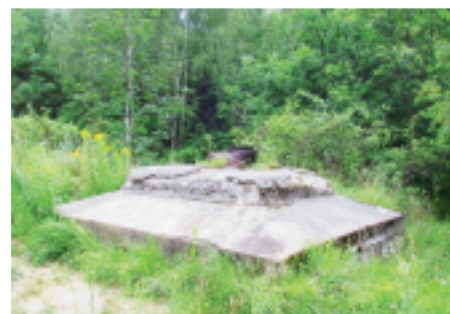
Fundament nogi masztu 3
