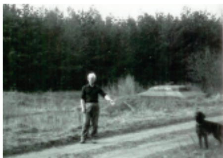
Widok nie istniejącego już fundamentu nogi masztu pierwszego, 09.04.1986.
